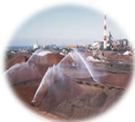
燃料・原料ヤード
