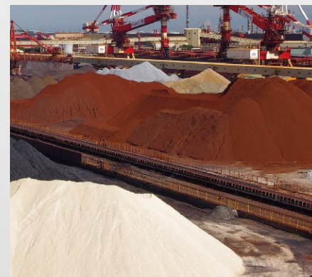
燃料・原料ヤード
