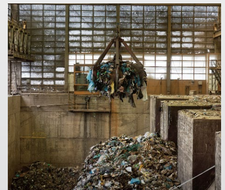
ごみピット・バイオマス
